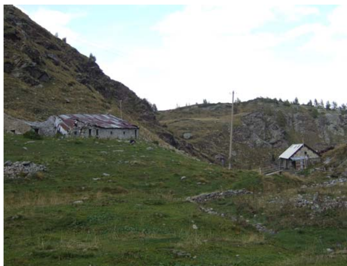
Fig. 2.4.8 - Alpeggio S. Stefano: a destra la cascina recentemente ristrutturata, a sinistra lo stallone in parte non più agibile
