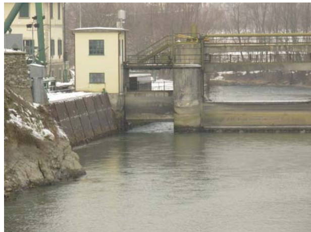
Fig. 2.4.21 - Particolare dell'opera di presa (a sinistra) e bocca di rilascio del DMV (a destra)
