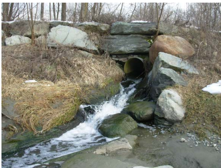
Fig. 2.4.24 - Immissione dello scarico ITAR di Teglio nel fiume Adda
