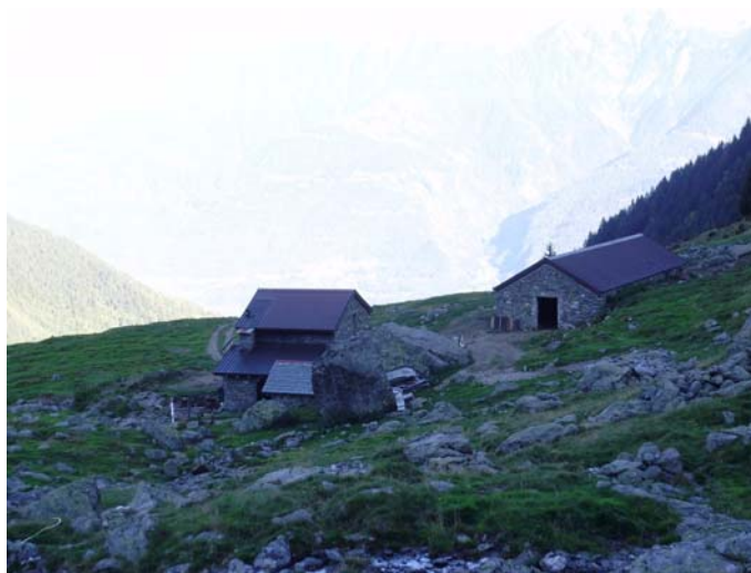
Fig. 2.4.12 - Campeì: fabbricato per il ricovero degli animali e fabbricato ad uso abitativo e per la caseificazione recentemente ristrutturato
